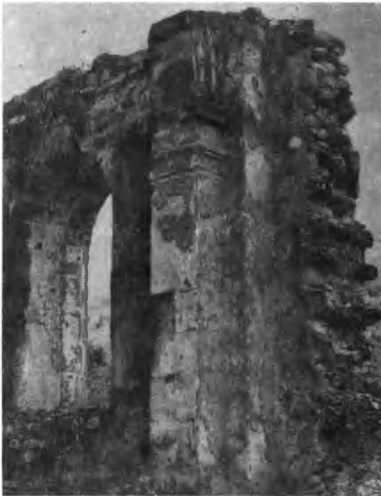
**Figura 35. Pilastra que sostiene el arco toral o triunfal. Vista general. Nótese la técnica constructiva que se empleó para levantar el muro de la fachada posterior: se acomodaron las piedras por secciones o tendidos alternados.**
