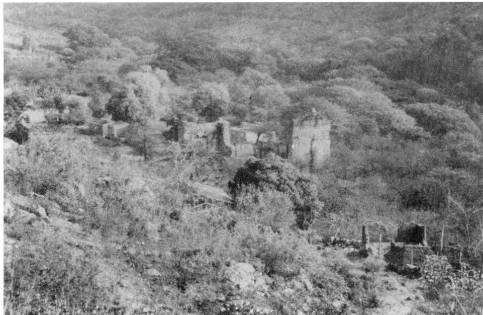
Figura 26. Fachada posterior del templo (nótese el contrafuerte colocado a lo largo de la sección intermedia del muro, cuya función era brindar mayor estabilidad). El deterioro de las fachadas laterales quizá se deba al empleo indiscriminado de piedra del templo para construir unidades habitacionales.
